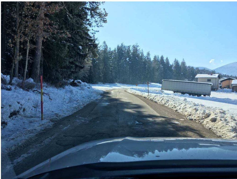
Slika 4: Pogled na traso
